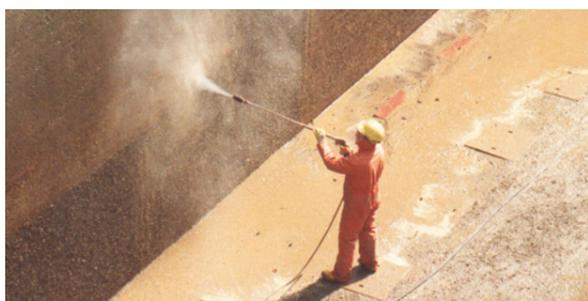
Der Turbofräser – die Kombi-Düse aus Punkt- und Flachstrahl – entfernt Schmutz und Farbe schnell und effektiv.
